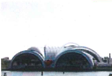
⑦東京辰巳国際水泳場（既設）
